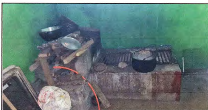
Foto 4: Mejoramiento y sustitución de polleto en mal estado por polleto nuevo e instalación de parrillas de metal.
