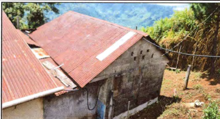
Foto 1: Sustrucción de lámina acanalada en mal estado por lámina troquelada.
