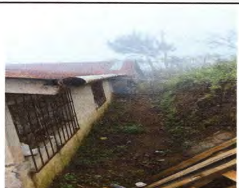
Foto 8: Sustrucción de canal o tubo plástico en mal estado, por canal metalico con sus respectivos pescantes.
