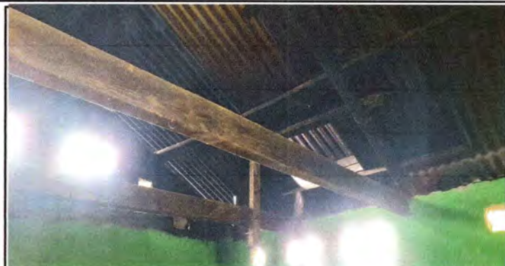
Foto 2: Sustrucción de estructura de madera por metal para mayor vida útil.
